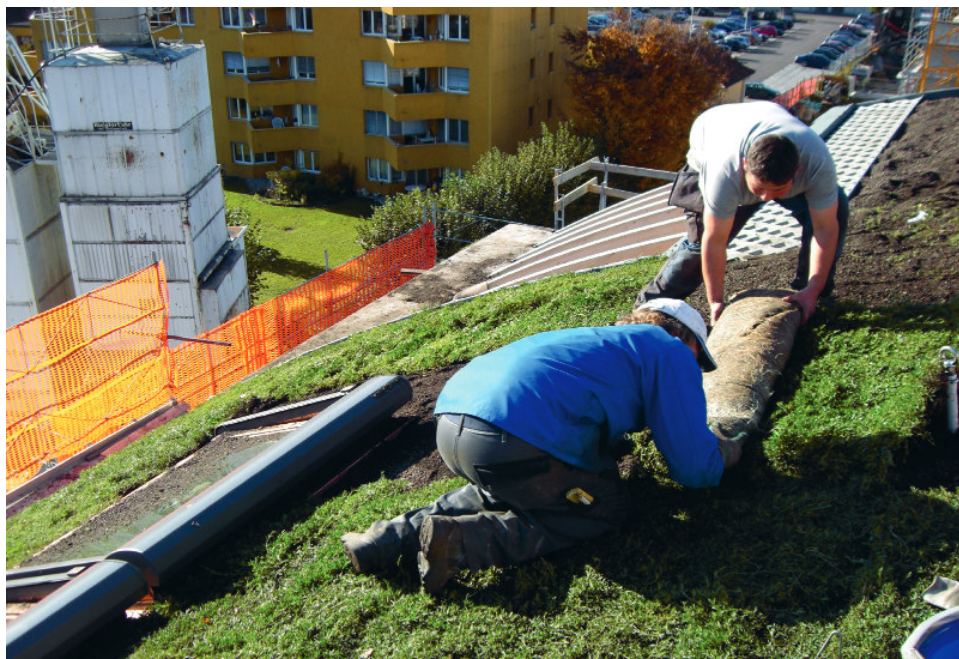
Abb.: Verlegen von Vegetationsmatten
