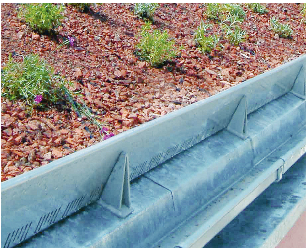
Abb.: Schubsicherung an der Traufe
