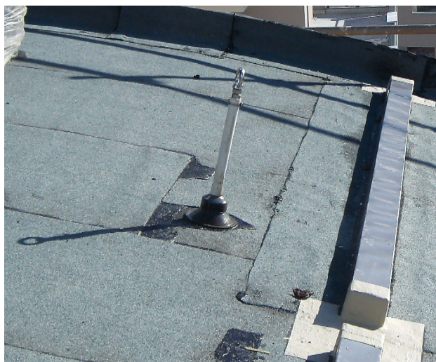
Abb.: Anschlagpunkt für Sicherungssystem
