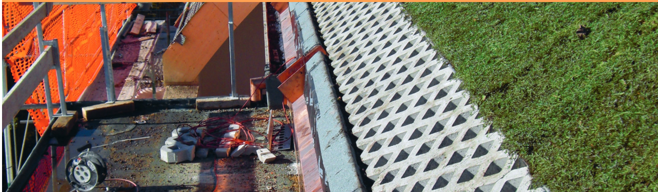
Abb.: Dachaufbau Dachbegrünung, Traufe mit Entwässerung
